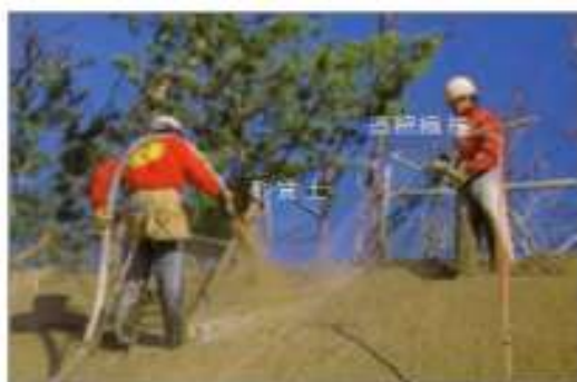
写真一 連続繊維補強土の施工状況〇〇〇〇
