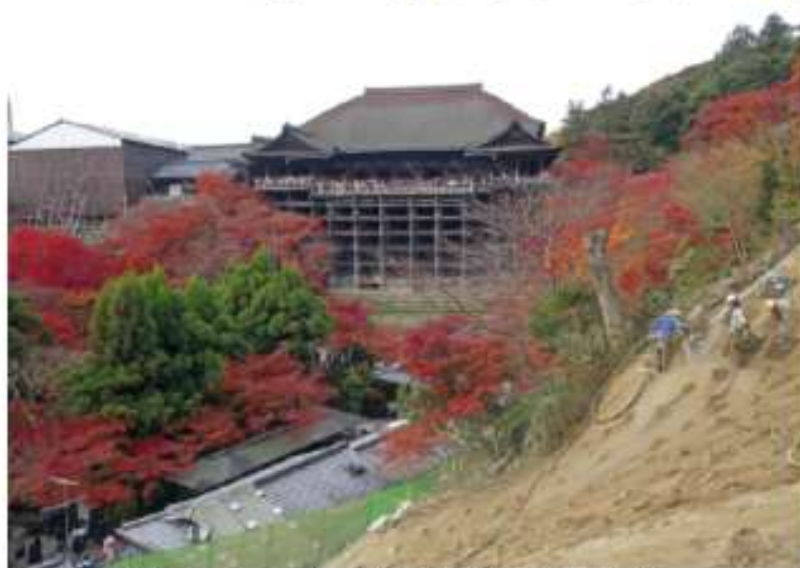
復旧工事の施工状況（平成 25 年の崩壊）
