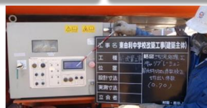
自走式改良機材料切出調整
