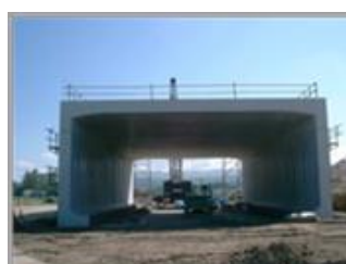
橋梁下部工基礎
