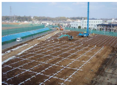
写真-2.1 水平ドレーン布設状況
