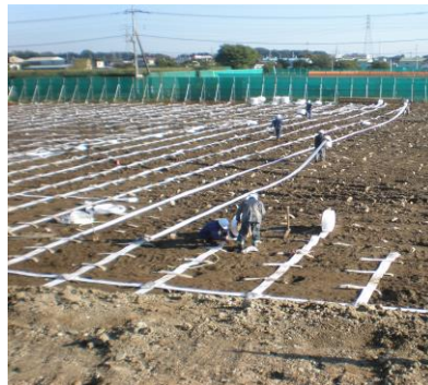
写真-2.2 水平ドレーン布設状況
