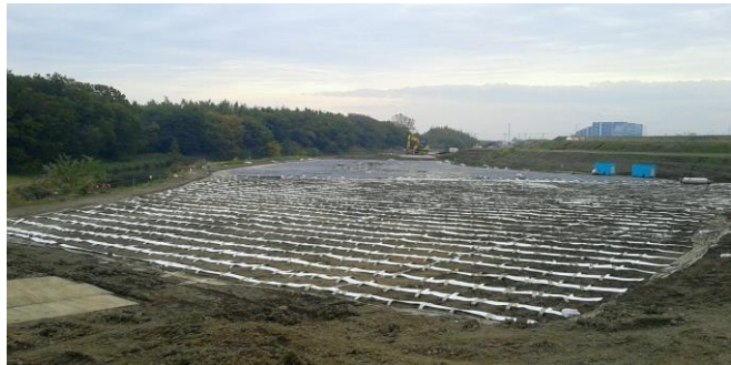
写真-2.1 施工状況
