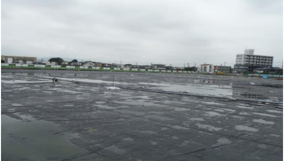
写真-2.2 真空運転状況
