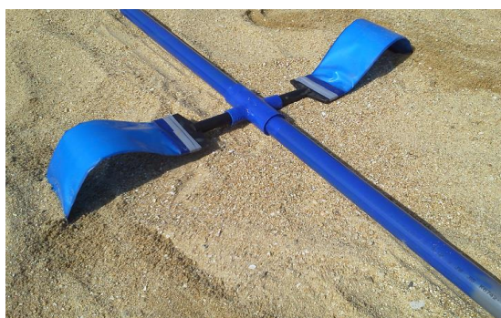
写真-1 ドレーンと集水管接続例
