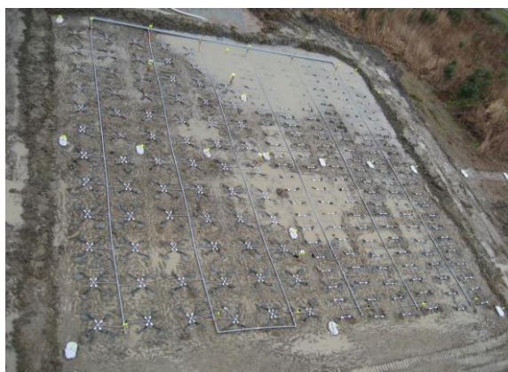
写真-3 施工例(全景)
