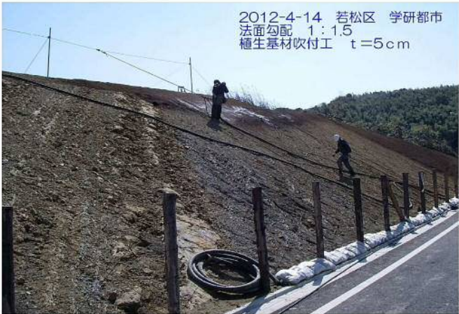
施工状況(ラス張工の省略)
