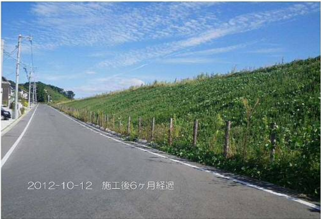
植生状況(施工後6か月経過)
