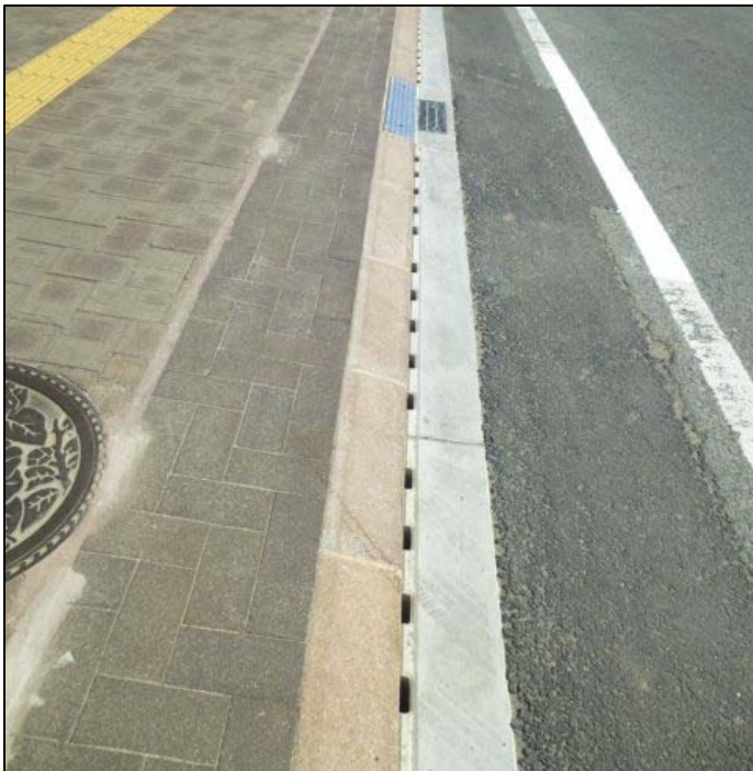
写真-1 施工現場写真
