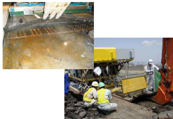
図4. 1号機による撤去状況
