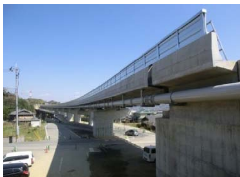
(1) 中谷川第一高架橋
