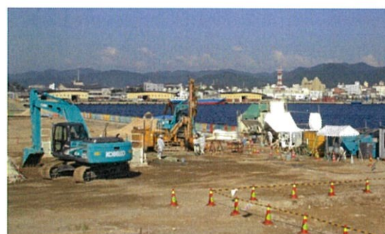
写真-3 護岸背面部の施工
