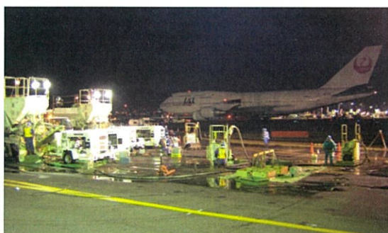
写真-2 空港誘導路における施工
