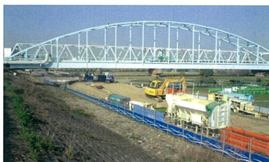
写真-4 橋梁下における施工
