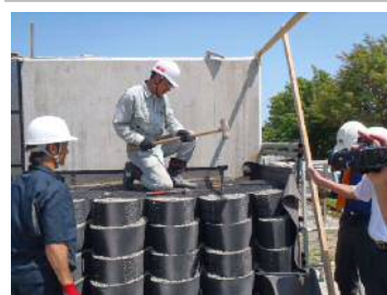
⑥アンカー筋打設
