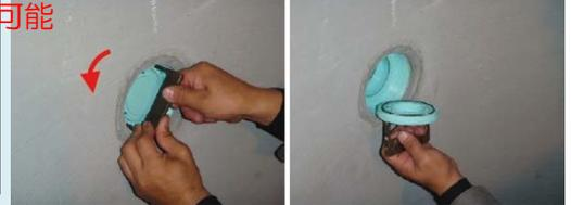
受圧板ユニットの交換により消散弁を再使用可
