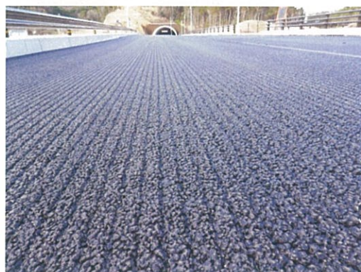
仕上がり路面の例
