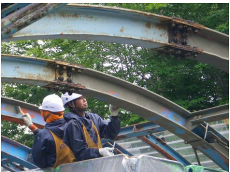
下塗り(防錆コートF)塗布
