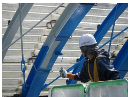
上塗り(防錆コートT)塗布
