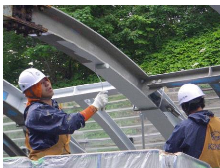
中塗り(防錆コートP)塗布
