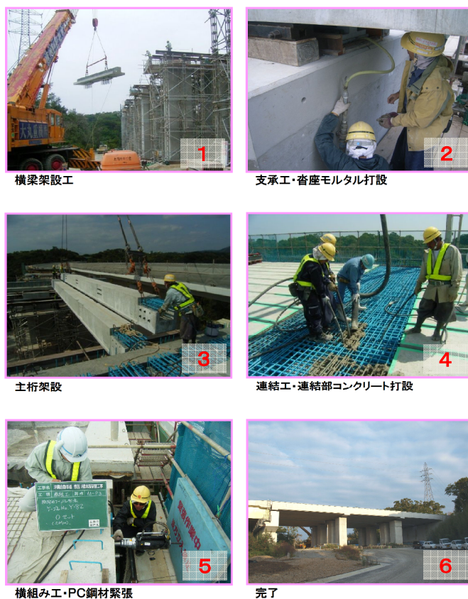
写真－1 SCBR工法の施工状況
