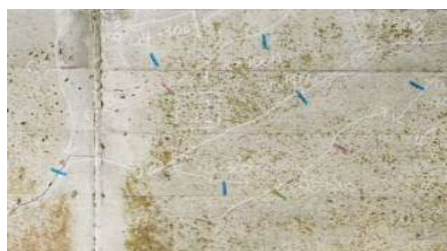
「Hurry」を使ったトンネルの亀裂調査時の使用事例
