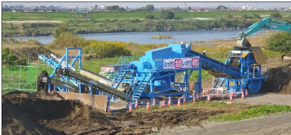
写真1-「すきとり表土」分別工法 全景
