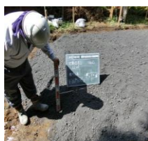
敷き均し厚さ確認
