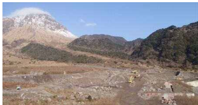
床固工工事全景
