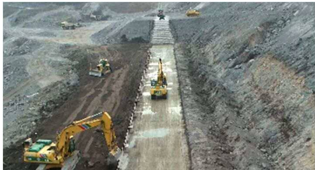
施工盛土および打設前清掃状況
