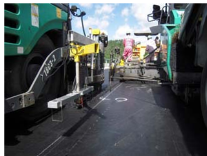
写真-3 施工状況(ホットジョイント部)
