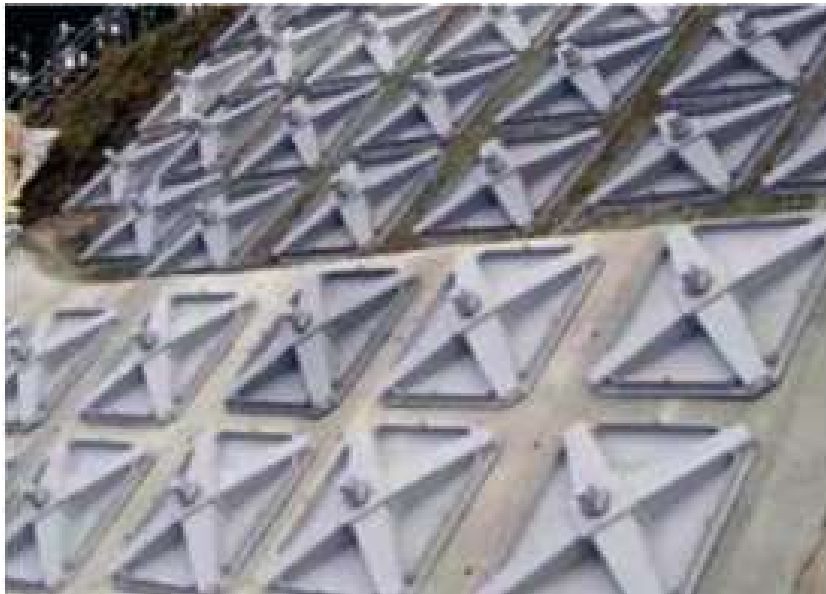
スーパーメタルフレームアンカー工法
