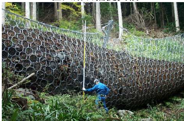
土砂捕捉実績
