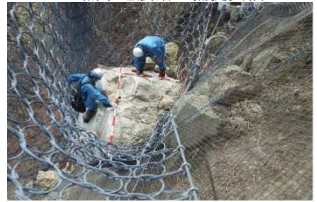
土砂捕捉実績
