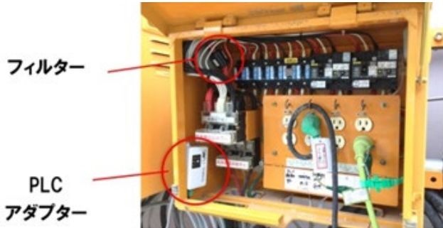
分電盤設置イメージ
