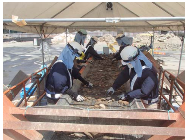
写真2 手選別ベルトコンベアによる選別
