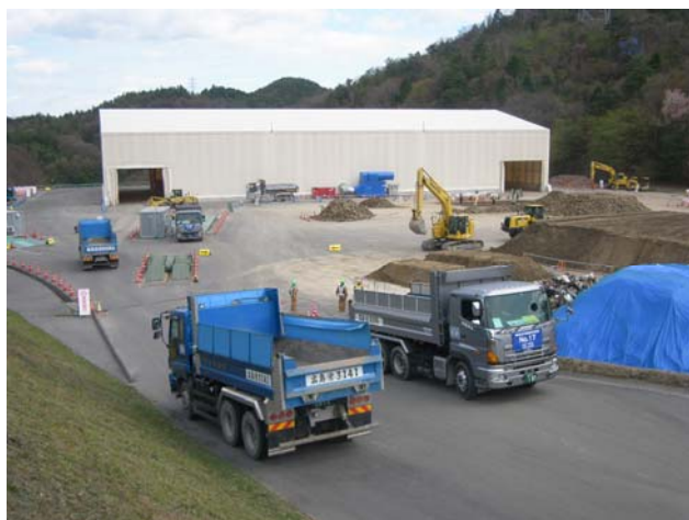
写真4 仮置場全景(写真奥:大型仮設テント)
