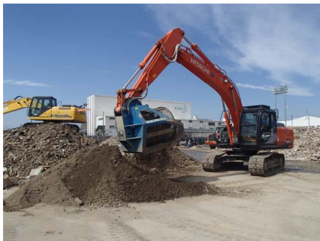
写真1 トロンメルバケットによる選別
