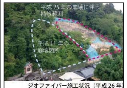
ジオファイバー施工状況 (平成 26 年)
