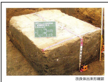
改良体出来形確認
