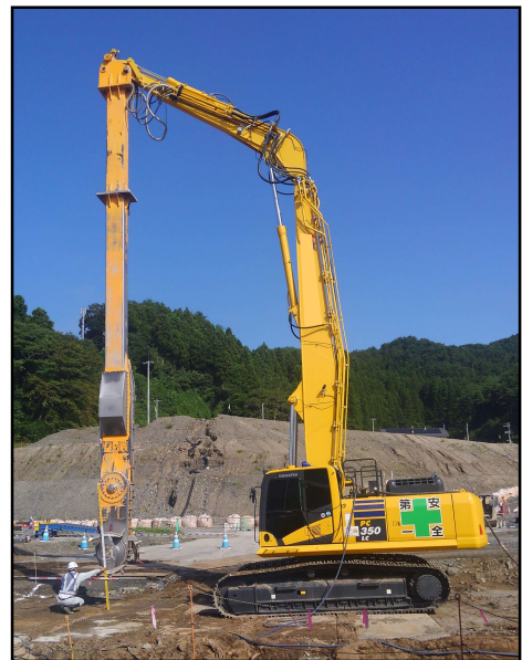
写真-4 13m 仕様改良機 施工状況
