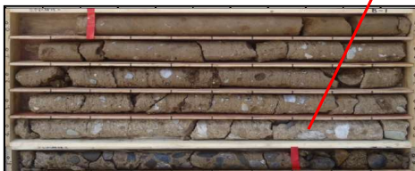
写真-2 改良体出来形
