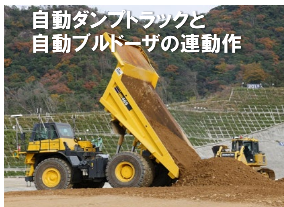
自動化施工状況
