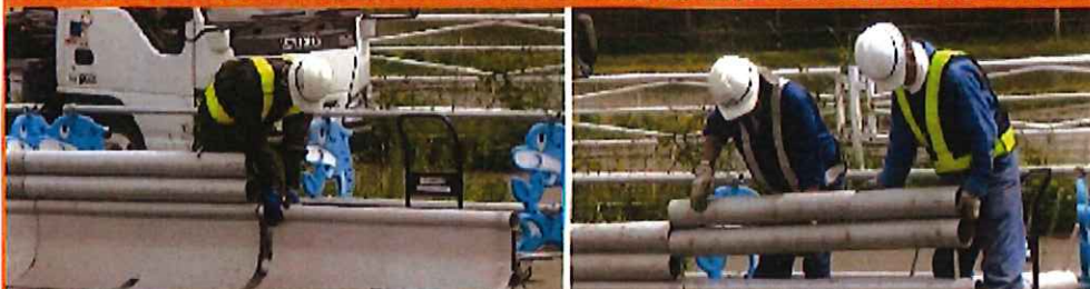
エレメント (1.50m) 下部の重量 50kg、上部の重量 30kg、簡単な施工で高い透水性を実現します
