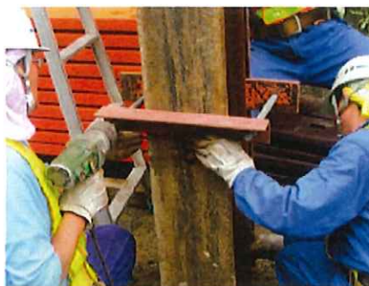
H形鋼支柱への取り付け状況
