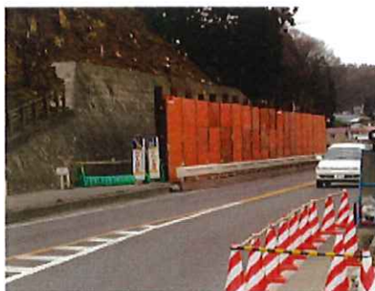
パネル式防護柵の設置状況
