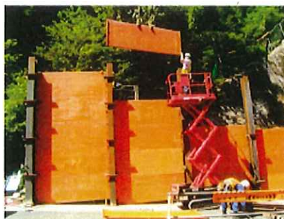
作業の状況 高所作業車使用
