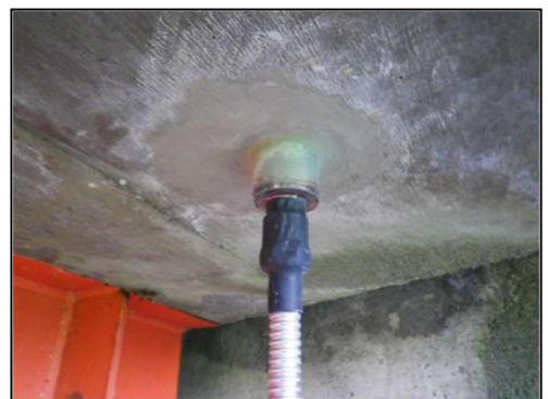
既設床版の補修工事で設置
