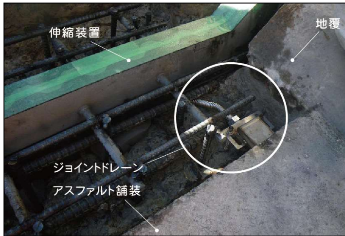
写真-1 施工写真
