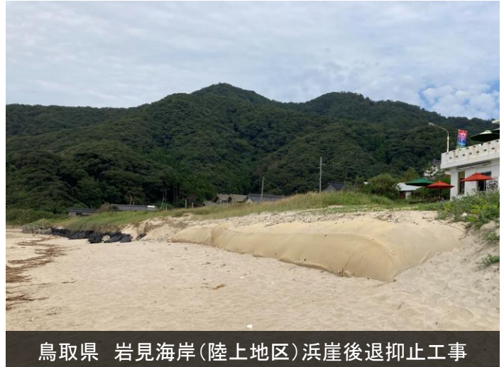
写真-1 ジオチューブDS 施工事例
