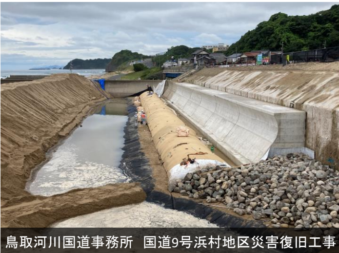
写真-1 ジオチューブDS 施工事例
