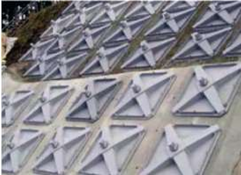
スーパーメタルフレームアンカー工法
