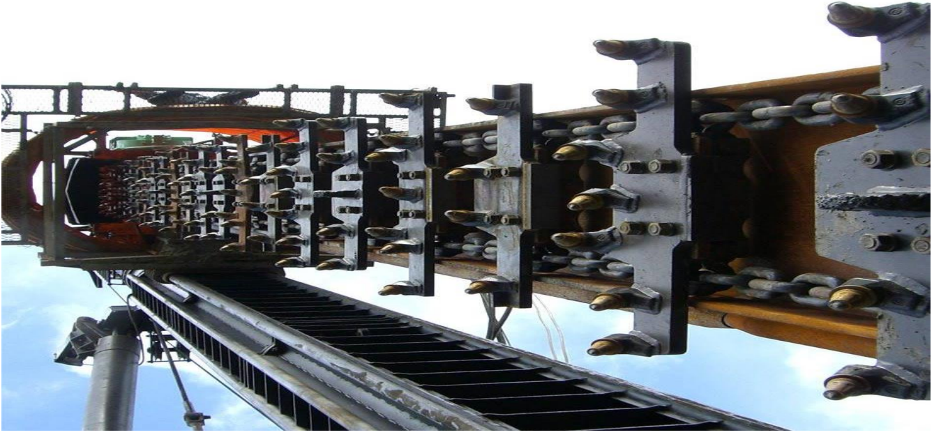
汎用杭打機にCCCを搭載
