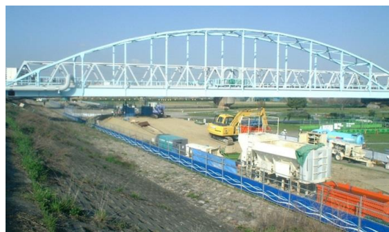
写真-4 橋梁下における施工
