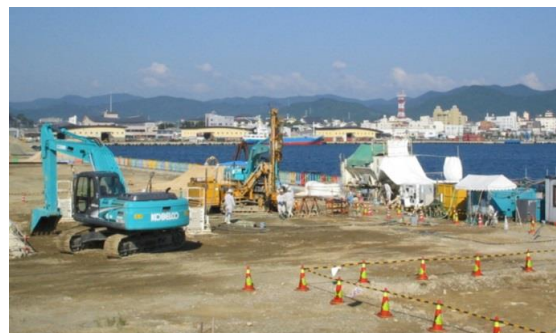
写真-3 護岸背面部の施工
