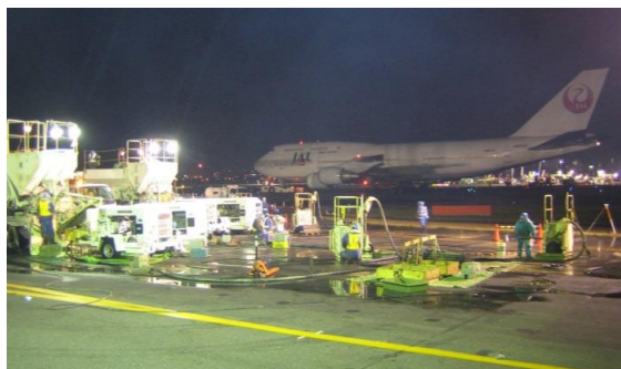
写真-2 空港誘導路における施工
