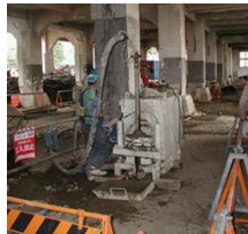
写真-5 空頭制限下の施工
