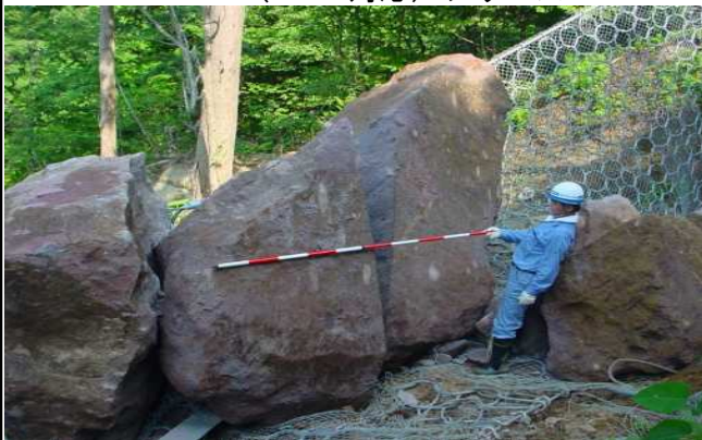
巨大落石捕捉実績
