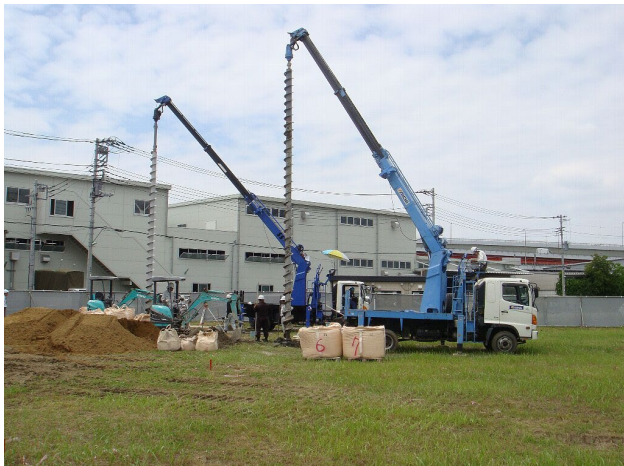
写真-1 SST工法による施工の様子
