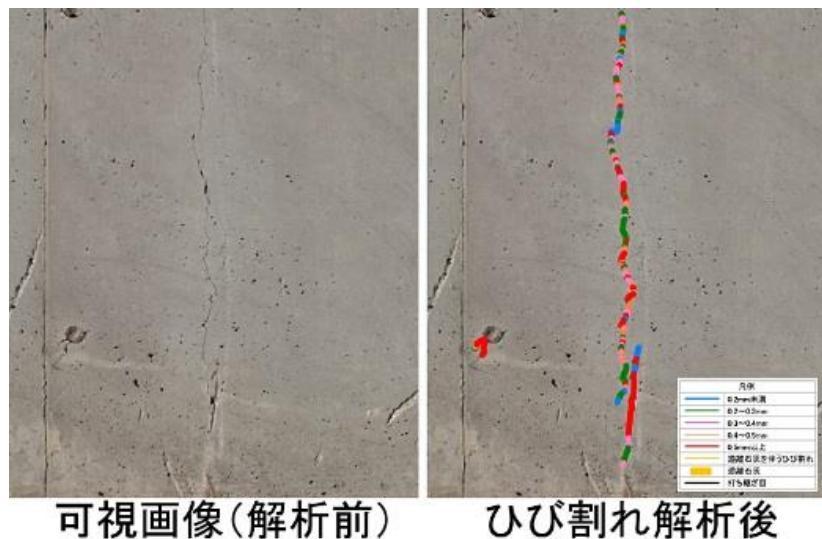
図-1 ひび割れの抽出例(擁壁)
