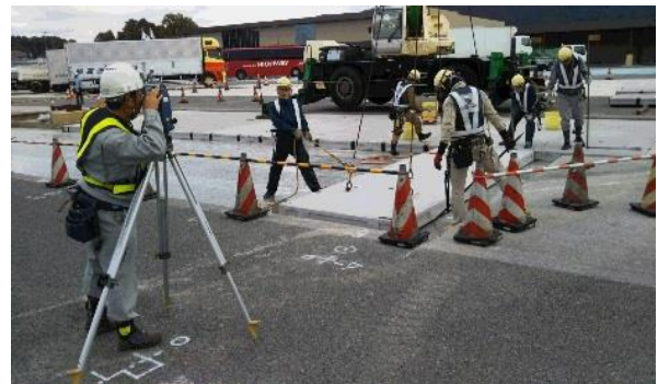
九州自動車道古賀SA施工状況
