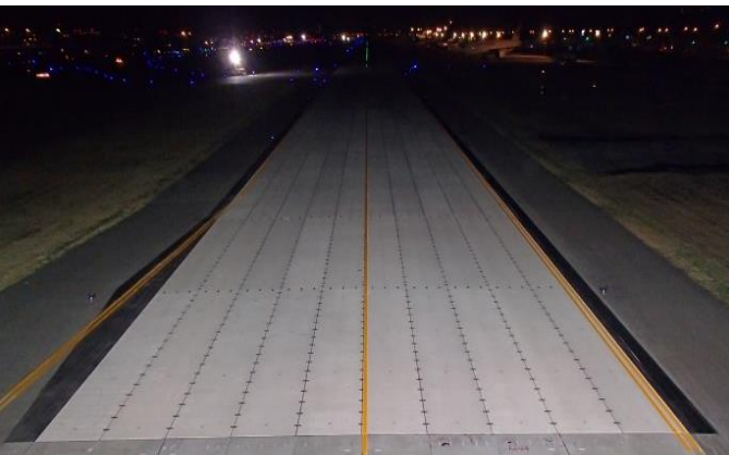
福岡空港誘導路完成写真
