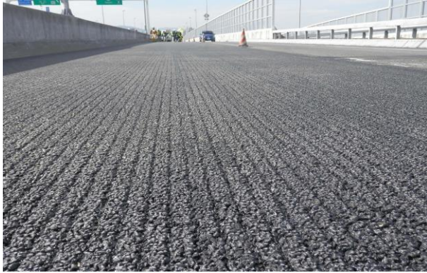
仕上がり路面の例 (福岡都市高速)
