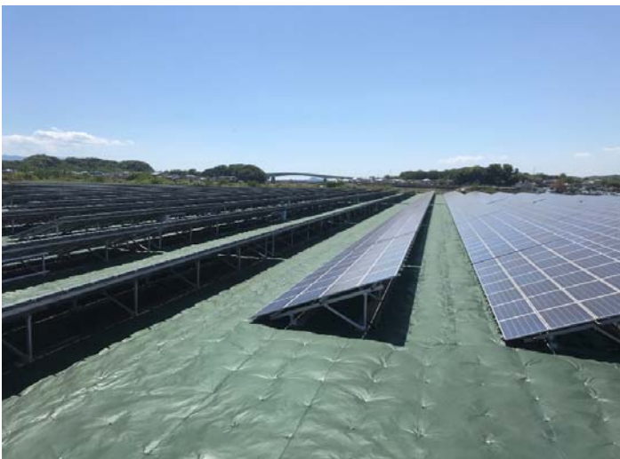
写3 施工事例 (太陽光発電施設)
