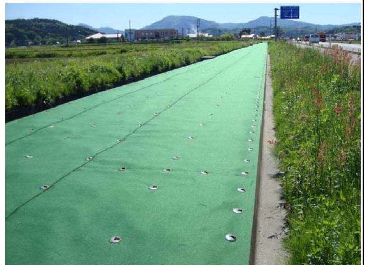
写2 施工事例 (平場部)
