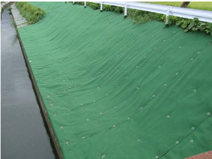
写1 施工事例 のり面部
