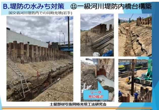
図-5 堤体内工事
