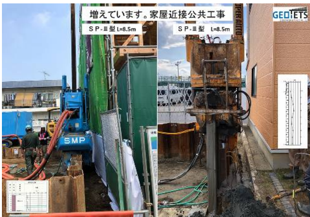
図-4 家屋近接工事
