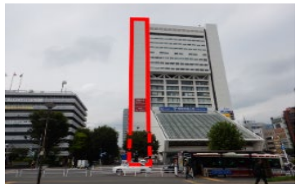
写真2 ラインドローンシステム調査状況
