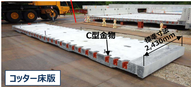
写真-1 橋梁用「コッター床版工法」の概要
