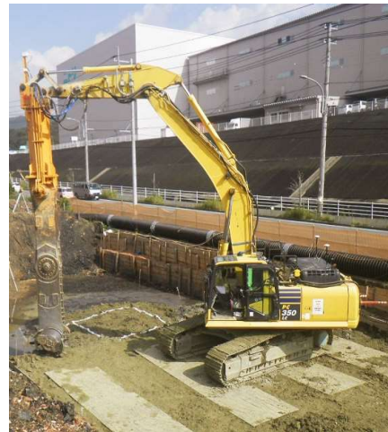
WILL-i工法 施工状況
