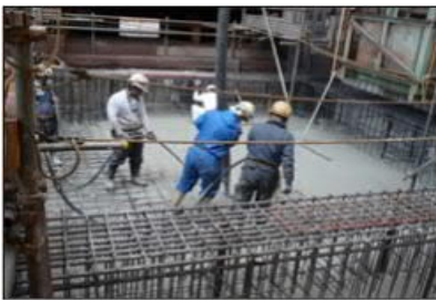
図7 クリーンクリートの打設状況 (製鉄所設備基礎コンクリート)
