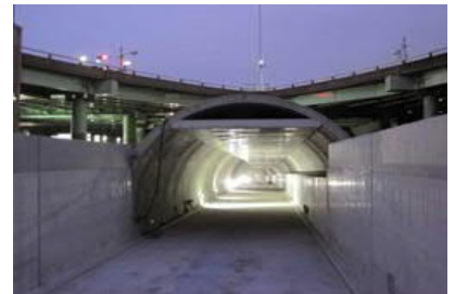
図9 U型擁壁底版への適用
