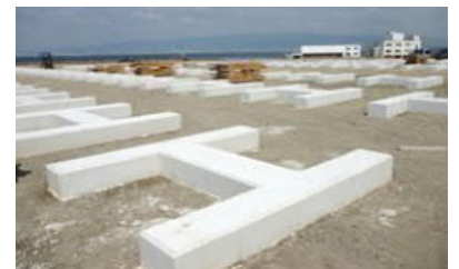
図12 メガソーラー基礎への適用
