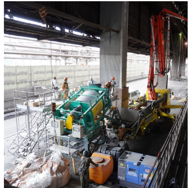
図-8 ポリマーコンクリート現場打設状況
