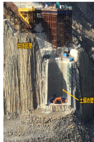
新工法による柱状節理の保全
