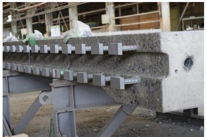
接合部配筋状況
