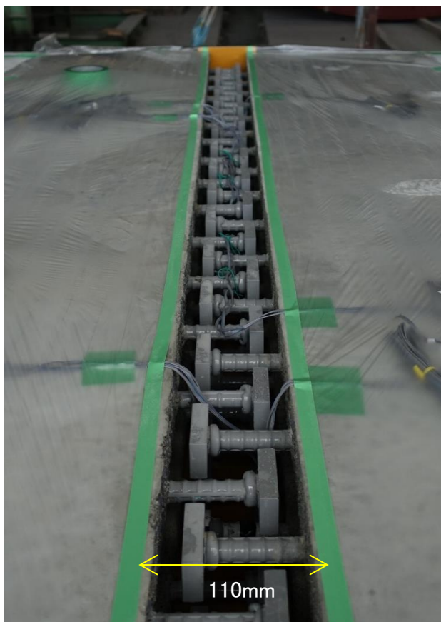
接合部配筋状況
