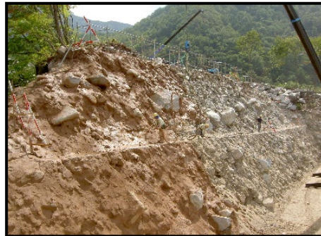
仮設吹付工実施状況
