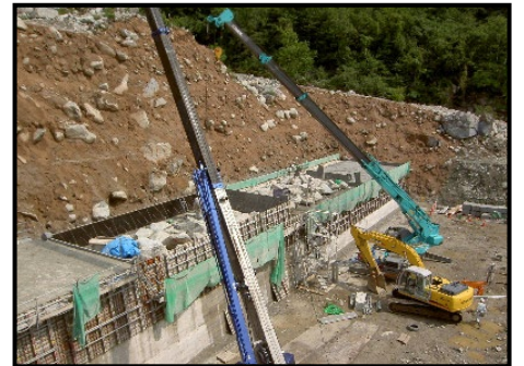
本施工実施状況
